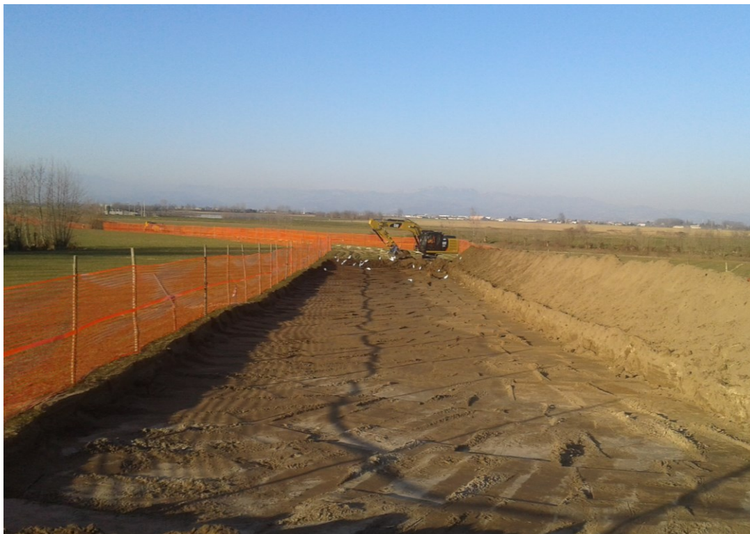
Fig. 2.3.2-A – Foto di apertura della pista di lavoro
