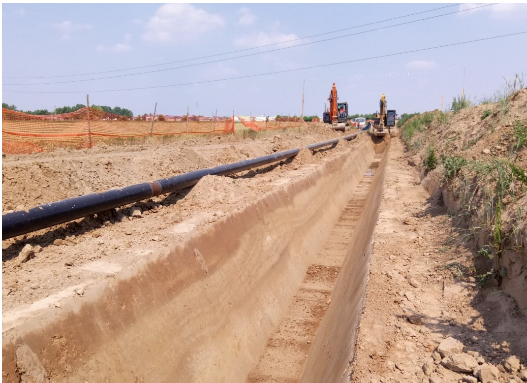
Fig. 2.3.3-A – Foto tipica di scavo della trincea
