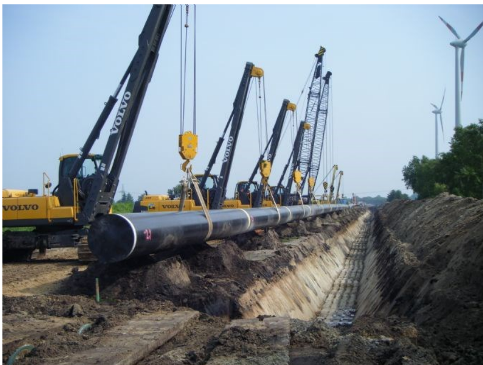
Fig. 2.3.4-A – Posa della condotta
